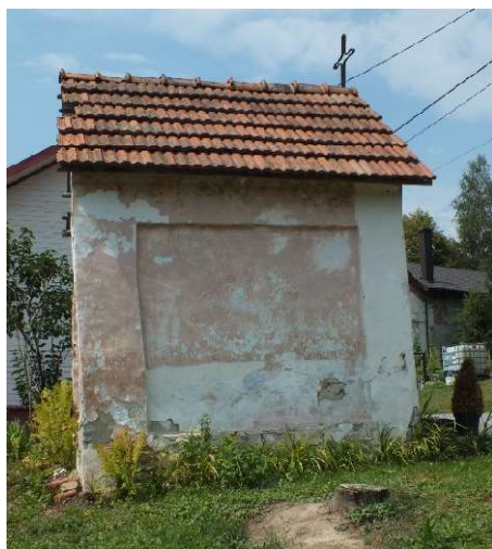
Fot. 4 Elewacja wschodnia
