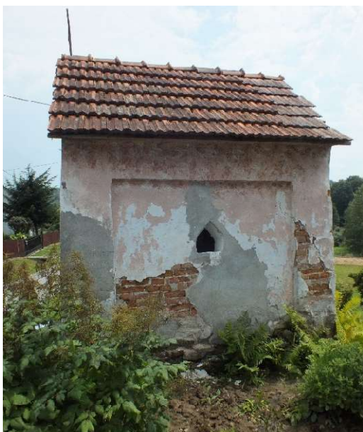
Fot2. Elewacja boczna - zachodnia
