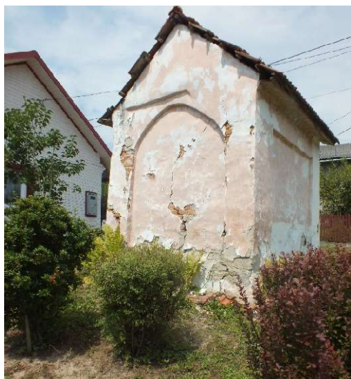
Fot. 3 Elewacja południowa
