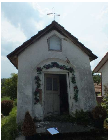
Fot. 1 Elewacja frontowa
